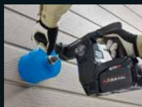
Foratura di un pannello con punta a tazza ( $\varnothing 160$  x 16mm)
