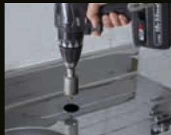
Perçage vertical dans le métal (Mode haut)
